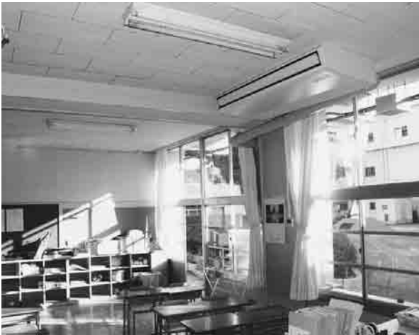
▲町内小中学校にエアコンを設置
