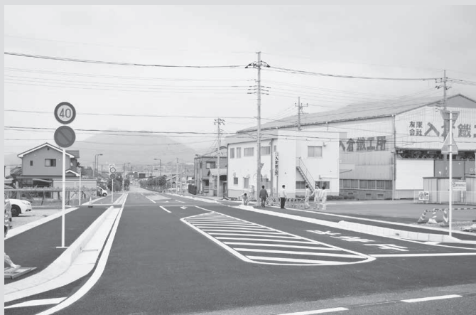
▲ 8 m 道路から大柵方面を撮影
