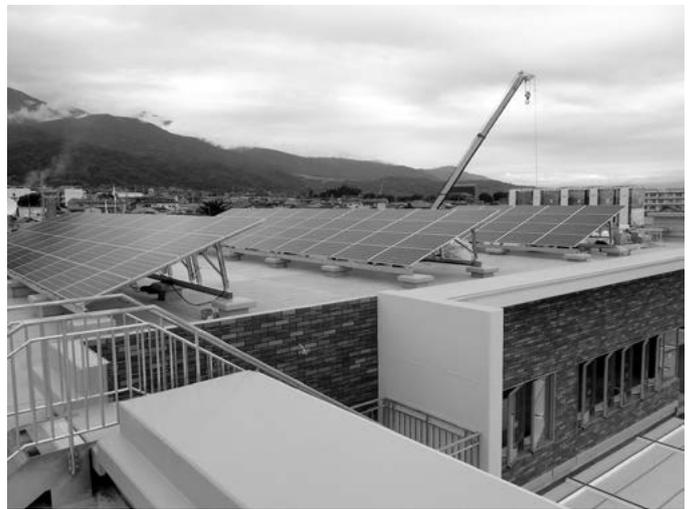
屋上に太陽光発電パネルを設置しました。最大42.7kwの発電をすることができます。
