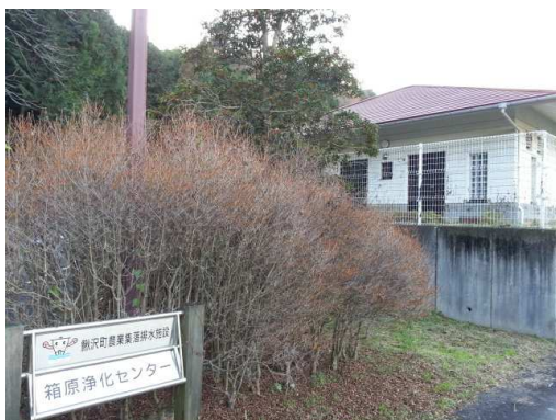
箱原浄化センター
