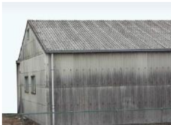
石綿含有スレート波板（屋根・外壁）
