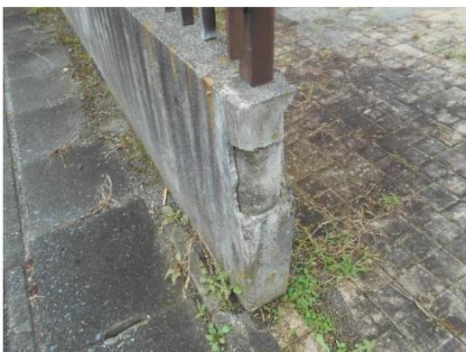
⑲ 基礎モルタルの破損（東側フェンス）
