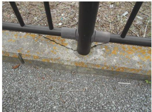
⑱ 擁壁の破損（北面）
