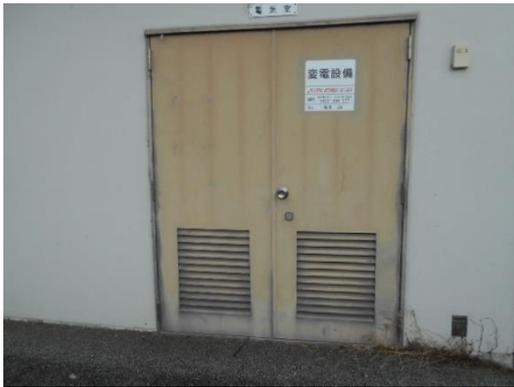
⑮ 入口ドアの塗装劣化（電気室）
