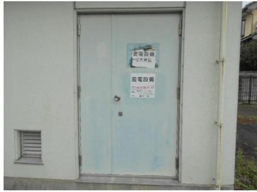
⑭ 鉄部塗装の劣化（受変電室）
