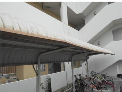
⑲ 屋根の破損、塗装の劣化（駐輪場）
