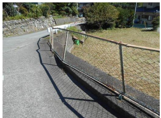
⑫ フェンスの破損・劣化
