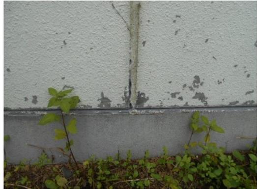
⑧ 外壁目地劣化、塗装の剥がれ（受変電室）
