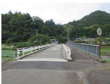
開柳橋&開柳橋歩道橋
