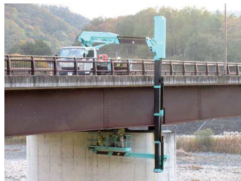
点検車による点検実施状況（鹿島橋）
