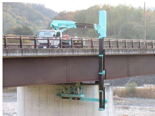
点検車による点検実施状況（鹿島橋）
