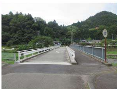
開柳橋&開柳橋歩道橋
