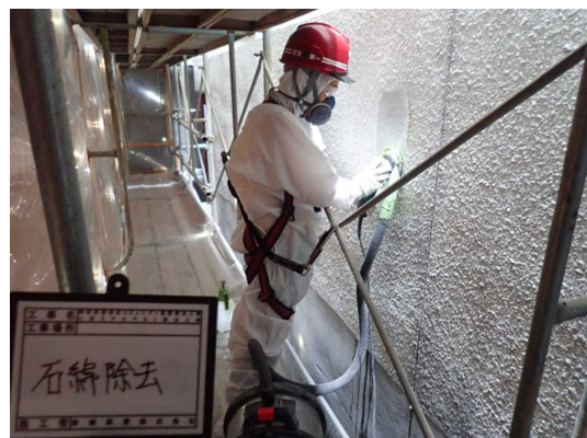
除去作業状況
