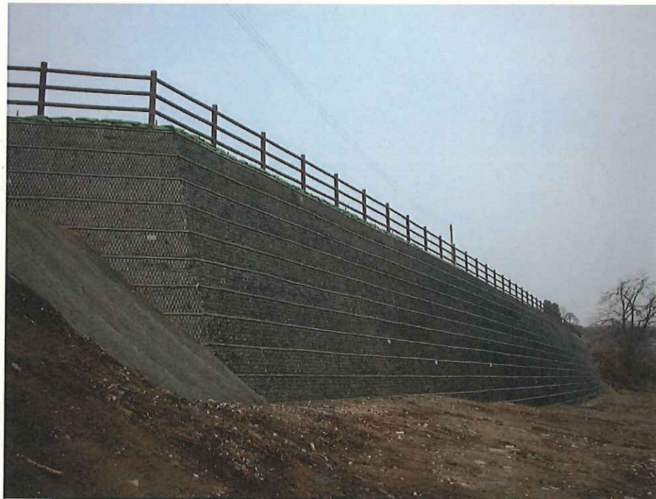
写真、補強土壁工法施工事例（メーカーHPより）
