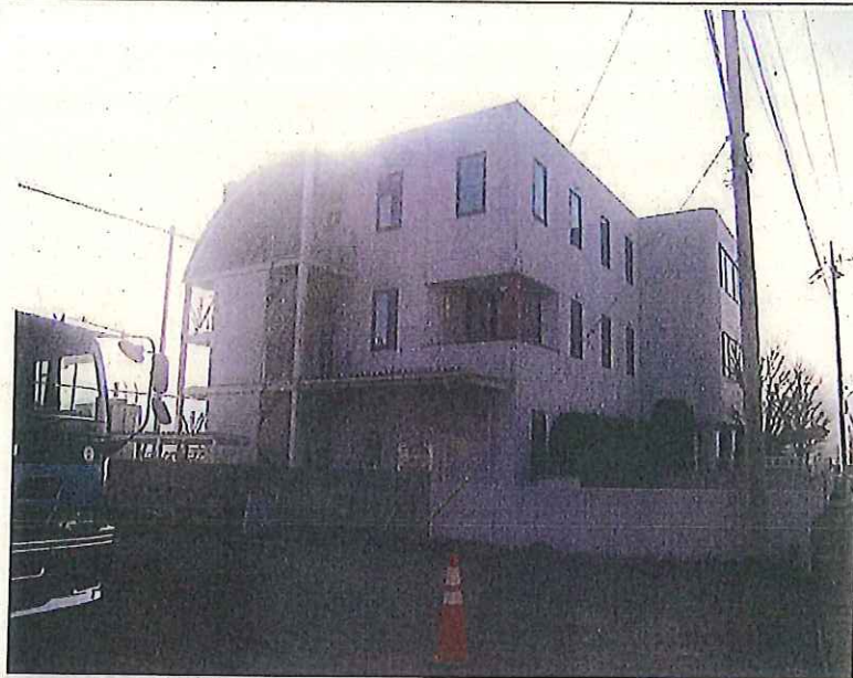
(株)Sakatec 社屋 現況写真 左面
