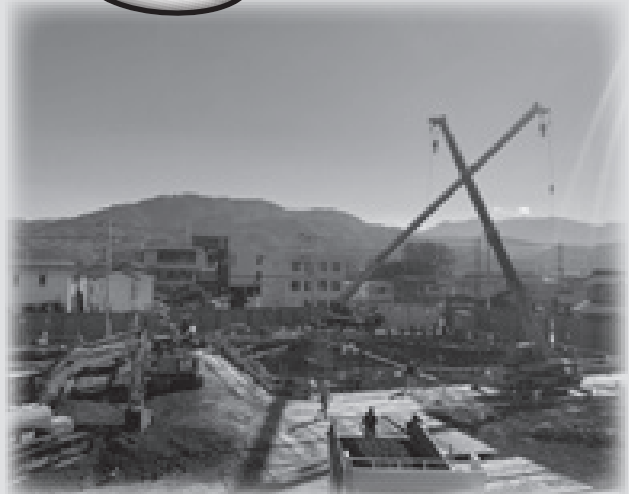
▲ 12月3日現在：基礎工事の様子
